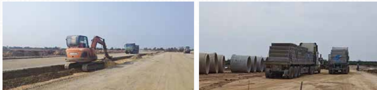
Công trường Dự án KĐT và Dịch vụ Tràng Cát
