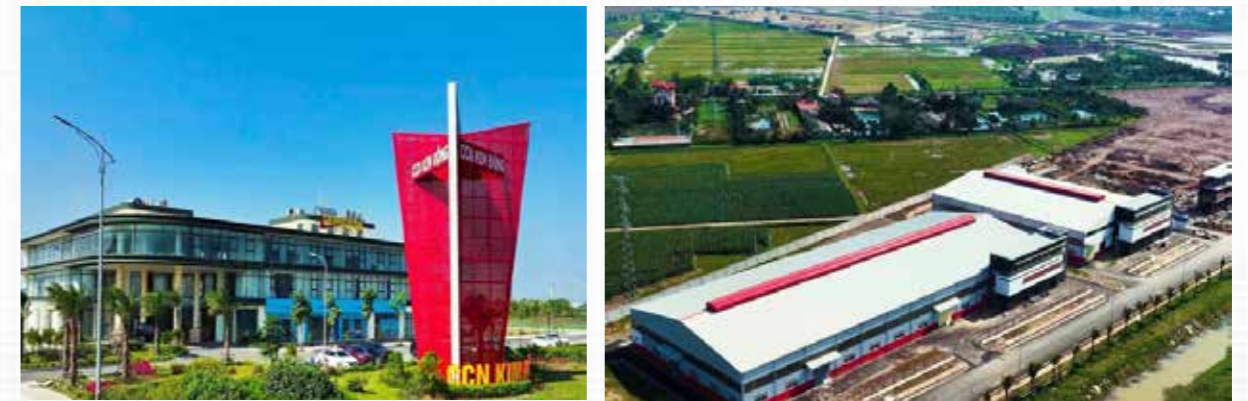
CCN Hưng Yên có tốc độ thu hút đầu tư, hoàn thiện hạ tầng cao nhất trong năm 2025
