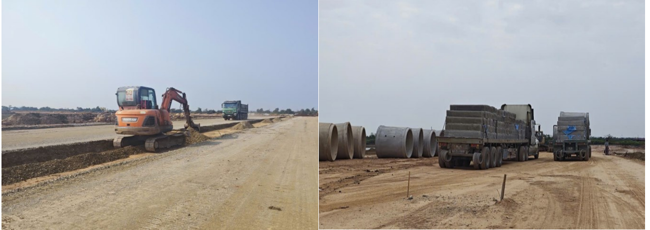
Công trường Dự án KĐT và Dịch vụ Tràng Cát
